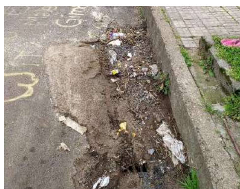
Foto 6 16. Boca de tormenta aterrada. Fuente: inspección set. 2020
